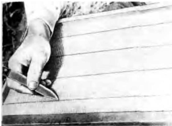
Рис. 14в. Прикрепление вошины к проволоке ножом
